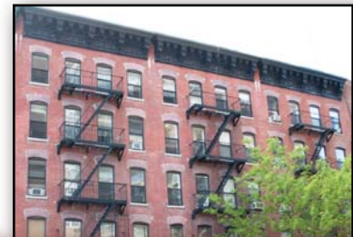
165-167-169 Ave C HDFC 165-167-169 Ave. C
